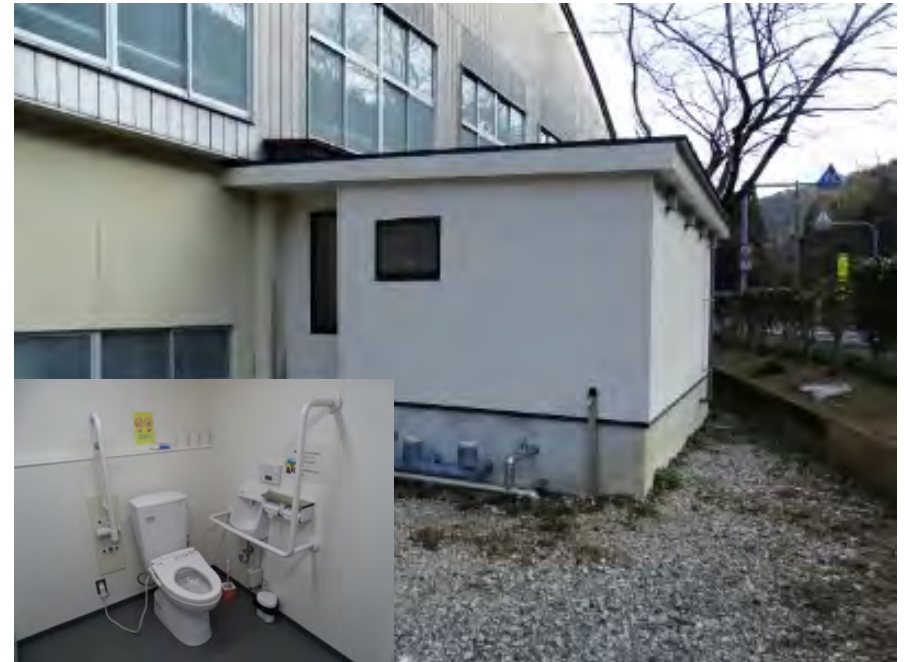
多目的トイレ設置後の三川内小中学校体育館
